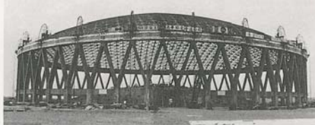
Gymnasium in Chong Cheng Memorial Sports Park after lifting of the roof / Die Sporthalle im Chong Cheng Memorial Sports Park nach der Hebung des Daches / Le palais des sports du parc mémorial Chong Cheng après levage du toit 中正紀念體育館
