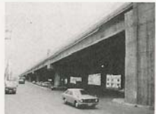
Dah-Du Road Viaduct in Taipei with post-tensioned I-beams / Dah-Du Strassenbrücke in Taipei mit vorgespannten I-Balken / Pont routier Dah-Du à Taipei avec poutres précontraintes 大渡路高架橋
