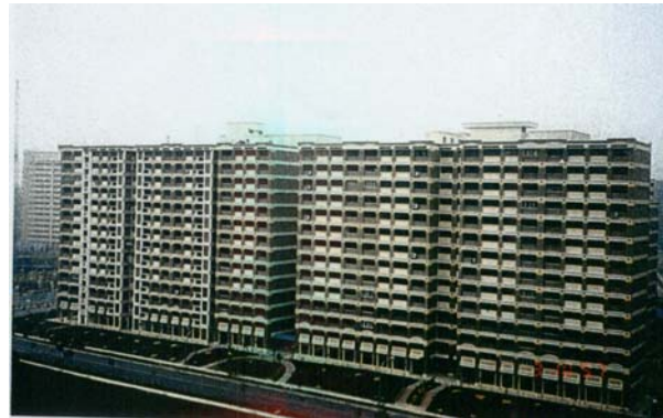
总承包住宅项目，共400多个单位
