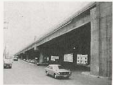
Dah-Du Road Viaduct in Taipei with post-tensioned I-beams / Dah-Du Strassenbrücke in Taipei mit vorgespannten I-Balken / Pont routier Dah-Du à Taipei avec poutres précontraintes 大渡路高架橋
