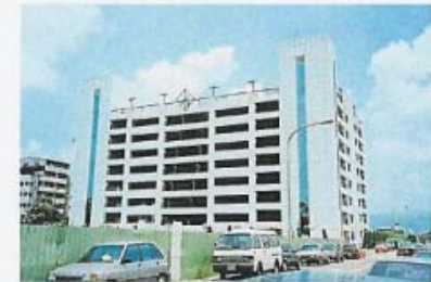
台中千城停车场 场铸柱, 预铸梁, 预铸预应力板
