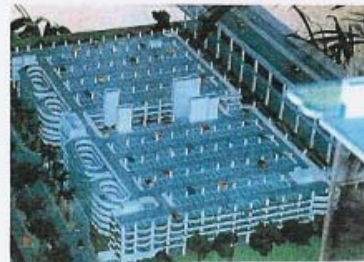
马来西亚吉隆坡 KLIA 国际机场停车场 6400 停车位, 预铸柱, 预铸梁, 预铸预应力板
