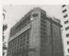
The Hsin-Kuang Building under construction / Das Hsin-Kuang Gebäude im Bauzustand / Le bâtiment Hsin-Kuang en construction 新光產物保險大樓
