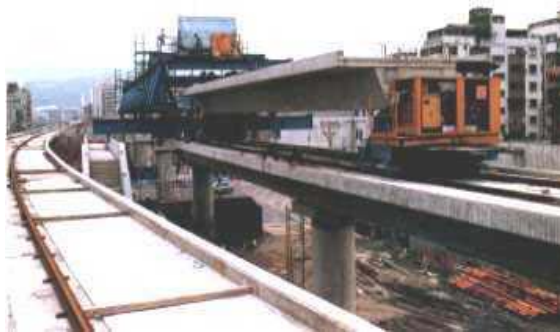
预制地铁高架轨道大梁
