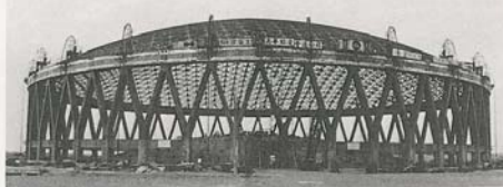
Gymnasium in Chong Cheng Memorial Sports Park after lifting of the roof / Die Sporthalle im Chong Cheng Memorial Sports Park nach der Hebung des Daches / Le palais des sports du parc mémorial Chong Cheng après levage du toit 中正紀念體育館
