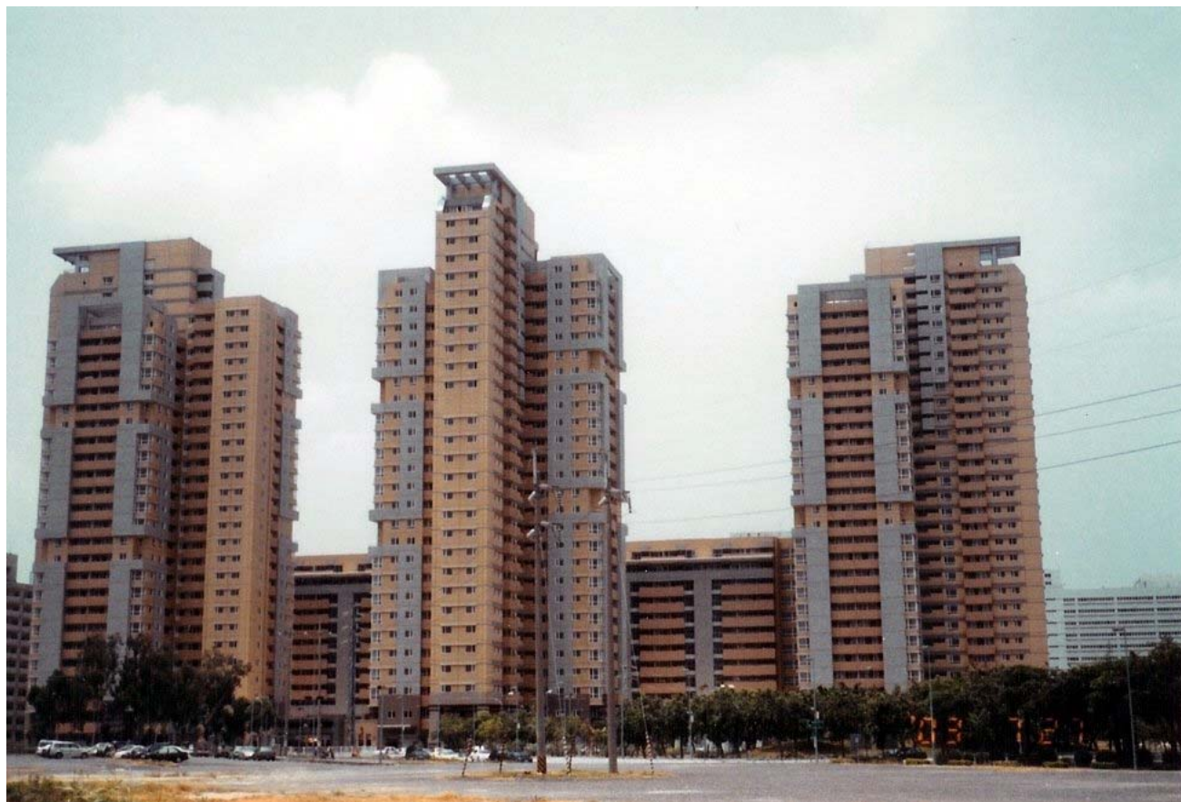
高雄長庚醫院醫護職務宿舍預鑄pc外牆版工程
