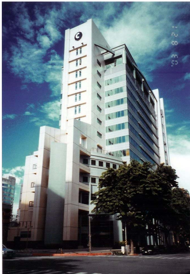
中華電信高雄至聖綜合大樓預鑄pc外牆版工程
