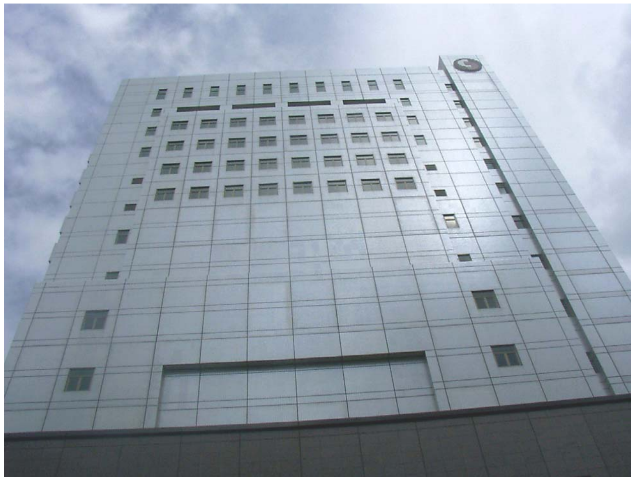
中華電信成功機房預鑄pc外牆版工程
